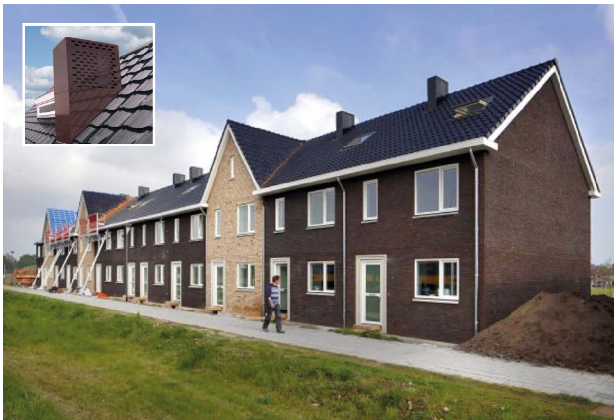
Figuur 6: Een lucht-waterwarmtepomp uitgevoerd als 'schoorsteen'.
