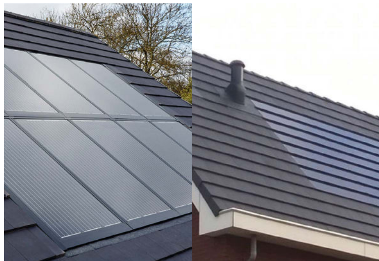
Figuur 10: In het dak geïntegreerde zonnepanelen.
