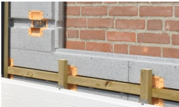
Figuur 5.5 Gevelisolatie aan de buitenkant
