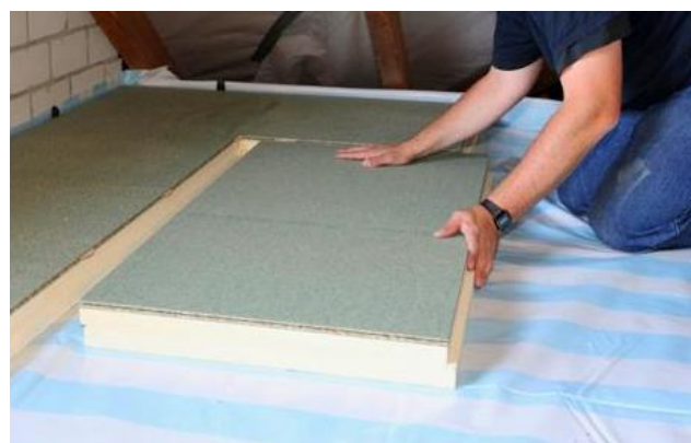
Figuur 5.2 Vloerisolatie bovenzijde
