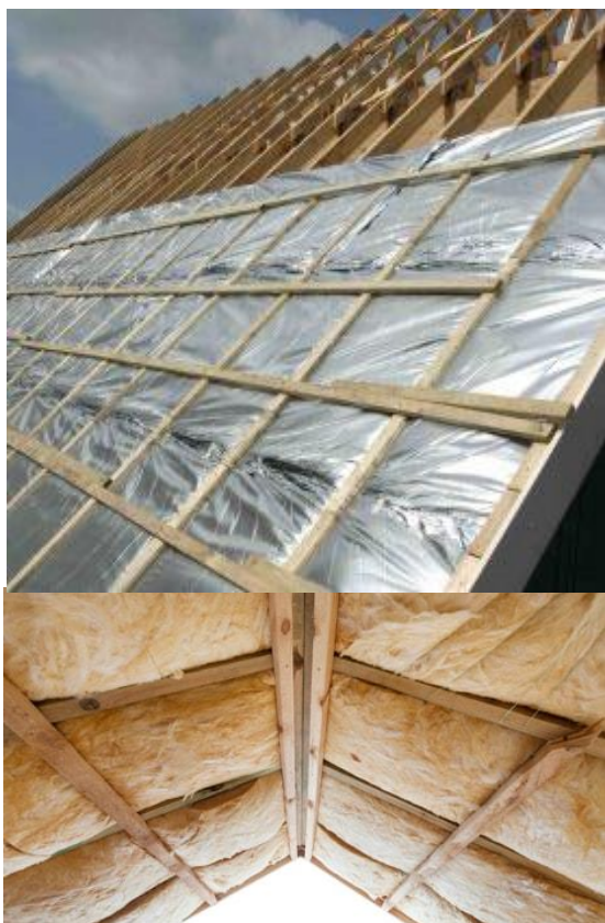
Figuur 5.8 Dakisolatie aan de binnen- en buitenzijde
