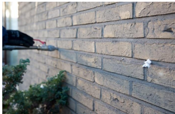
Figuur 5.4 Aanbrengen spouwmuurisolatie in bestaande gevel
