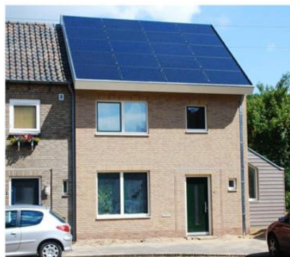
Buitengevelisolatie, uitgevoerd voor één woning
