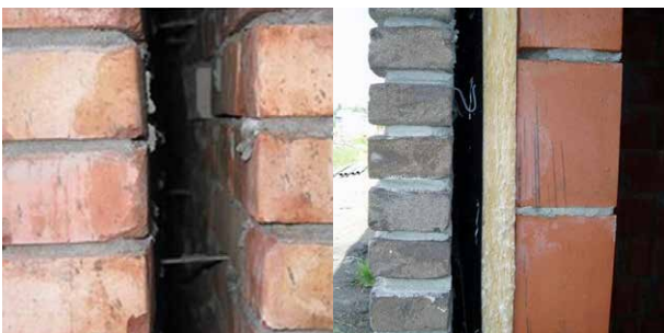
Spouwmuur zonder isolatie
