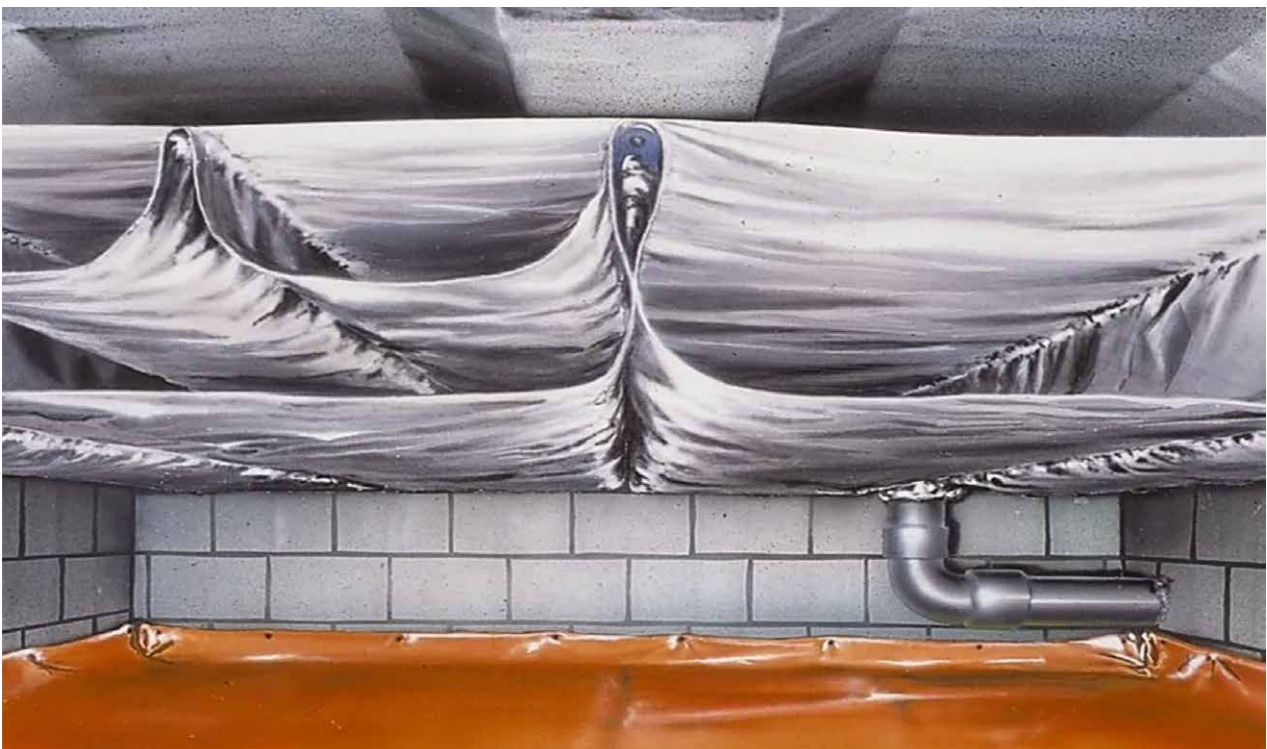
Dampremmende laag op de bodem en vloerisolatie
