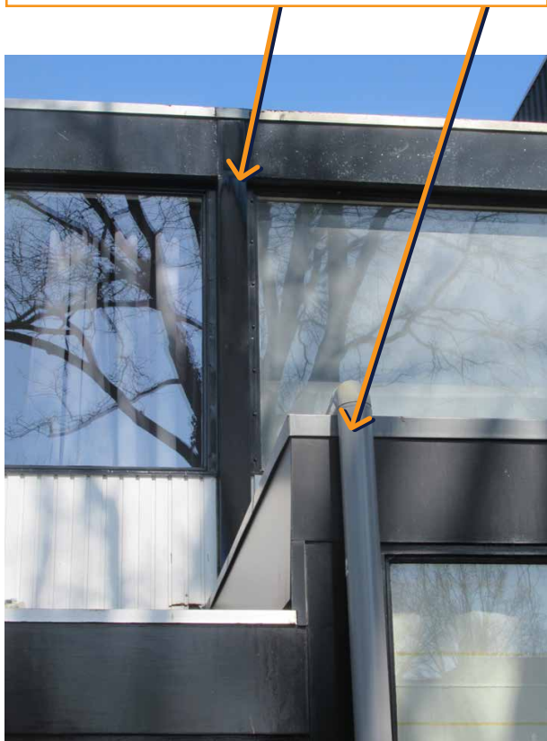
Foto 9: hemelwaterafvoer (straatzijde)
