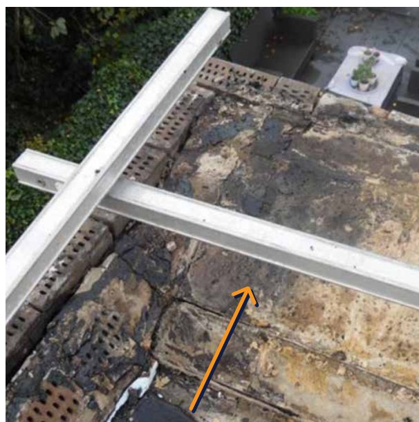
Foto 3: opname hoek zijgevel/opbouw en badkuip-opstand en zijmuur begane grond hoekpand (holle steen) met spouw.
