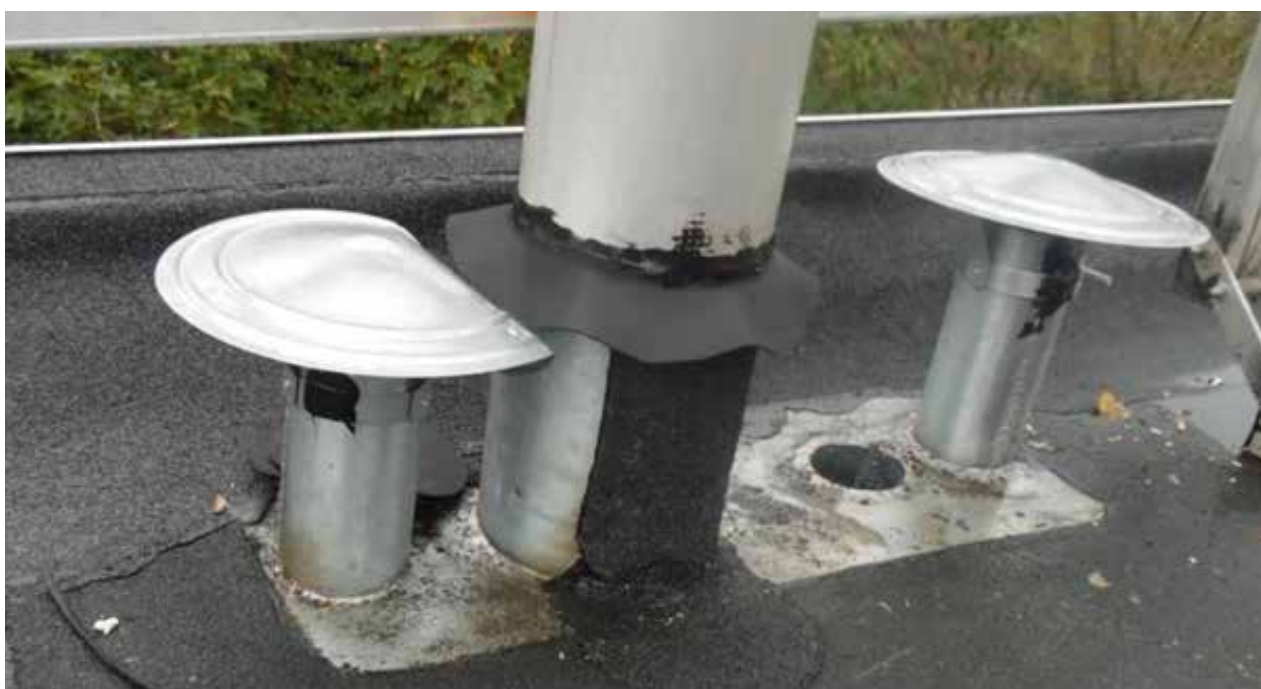
Foto 6: Idem, halverwege renovatie van dit dak
